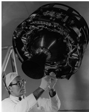
FIGURA 7 – Satélite SYNCOM em Construção
